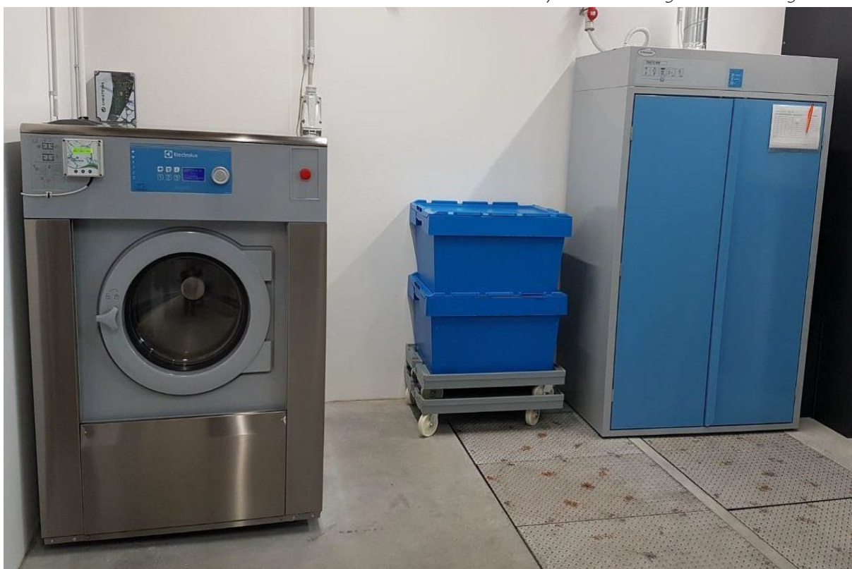
Bild 1. Waschraum im Feuerwehrhaus mit Waschmaschine und Trockenschrank für Schutzkleidung und Atemschutzgeräte
