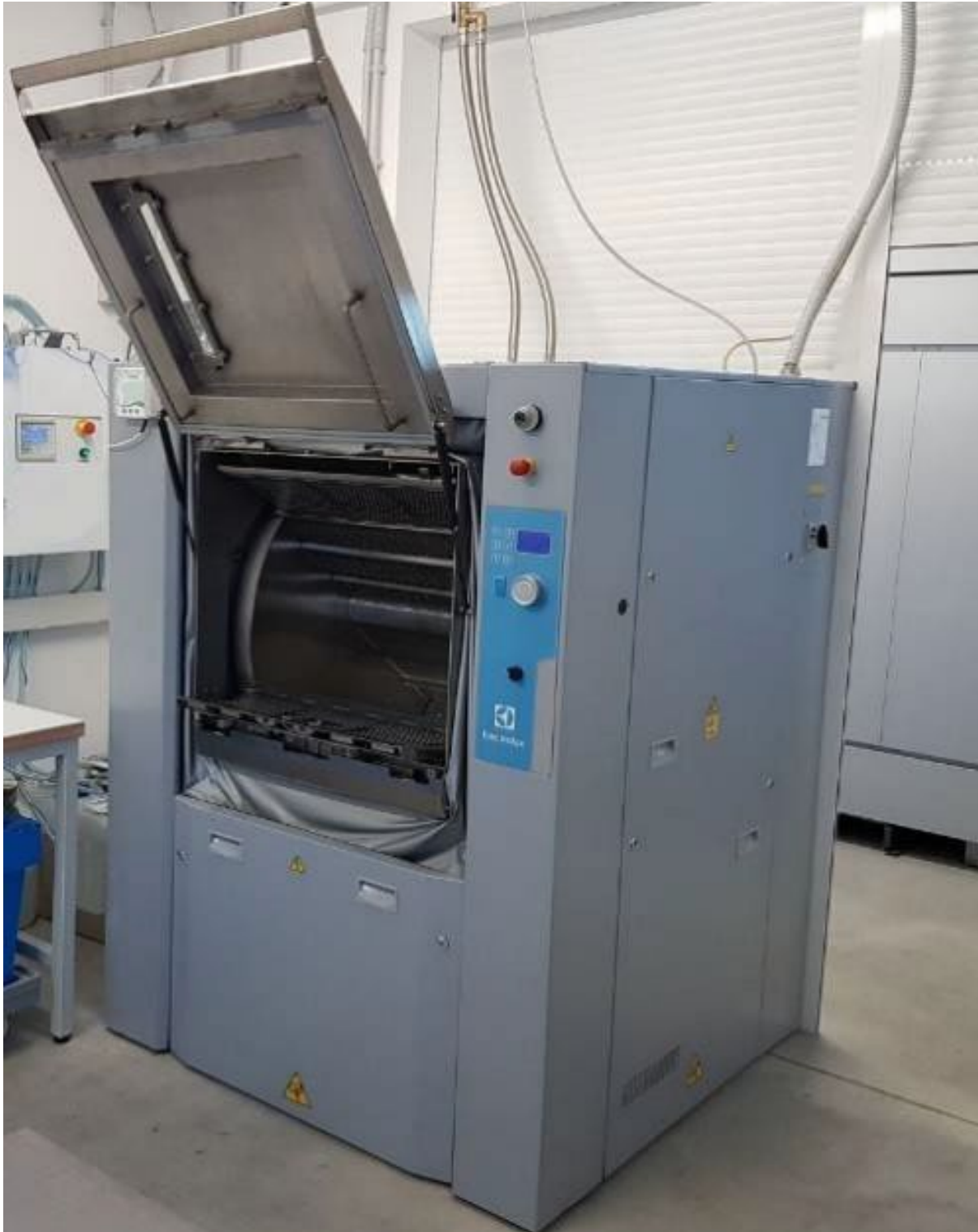
Bild 2. Barriere-Waschmaschine bei Feuerwachen, die eine Unterteilung in eine kontaminierte Zone und eine saubere Zone ermöglichen in Räumlichkeiten zur Handhabung von z. B. Schutzkleidung und Atemschutzmasken.
